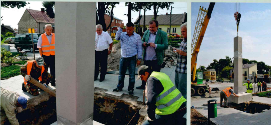
Montaż postumentu Pomnika Niepodległościowego na rynku w Ożarowie ufundowanego przez Grupę Ożarów S.A.
